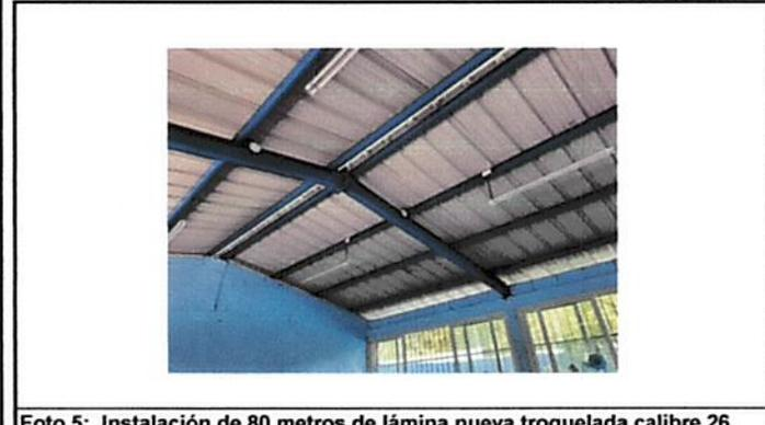
Foto 5: Instalación de 80 metros de lámina nueva troquelada calibre 26
