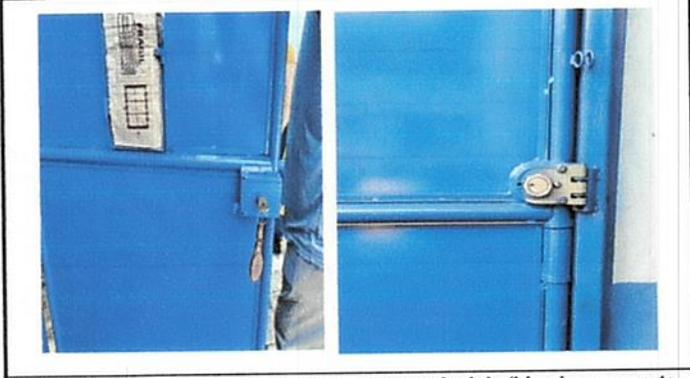
Foto 8: Mantenimiento de portón de ingreso principal (Limpieza, soporte, cambio de 2 chapas y .pintura)
